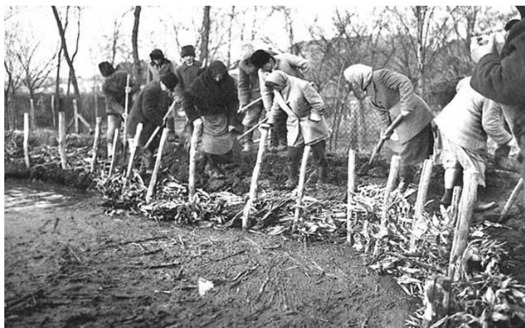
10. ábra Jászolgát-építés rőzsefonattal (töltésmagasítás, hullámverés elleni védelem), 1963 márciusa [19]
