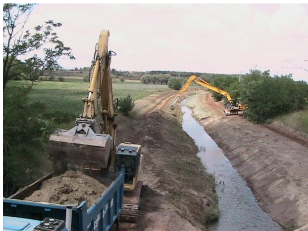
10. kép: A Torna patak árvízi védműveinek kiépítése. Készítette: a szerző
