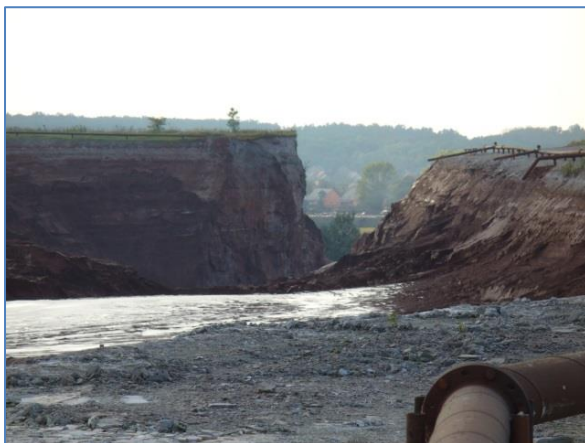
2. kép: A kiszakadt X. számú kazetta. Készítette: a szerző
