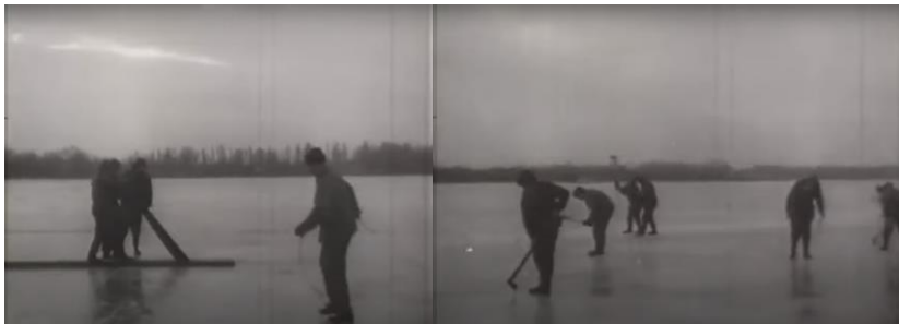
19. ábra Jégtörés kézi eszközökkel, fűrésszel, csákányokkal [29]
