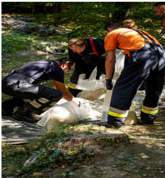
7. kép: nyúlgát építés (forrás: FMKI)
