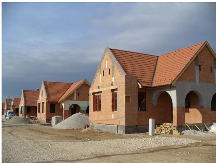
8. kép: A készülő lakópark. Készítette: a szerző
