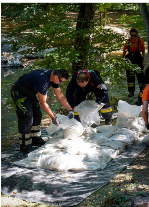
3. kép: Nyúlgát építés (forrás: FMKI)
