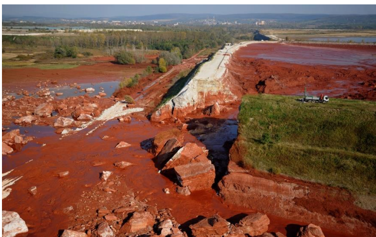
1. kép: A Mal Zrt. X. kazettájának kiszakad sarka Fotó: Katasztrófavédelem
