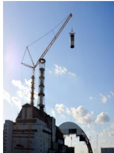
Szellőző rendszer átalakítása
