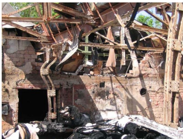
15. ábra Tűzfal stabilitás vesztese és leomlása
