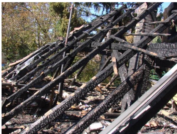
12. ábra Beégés nyomok mélységének változása a szarufákon
