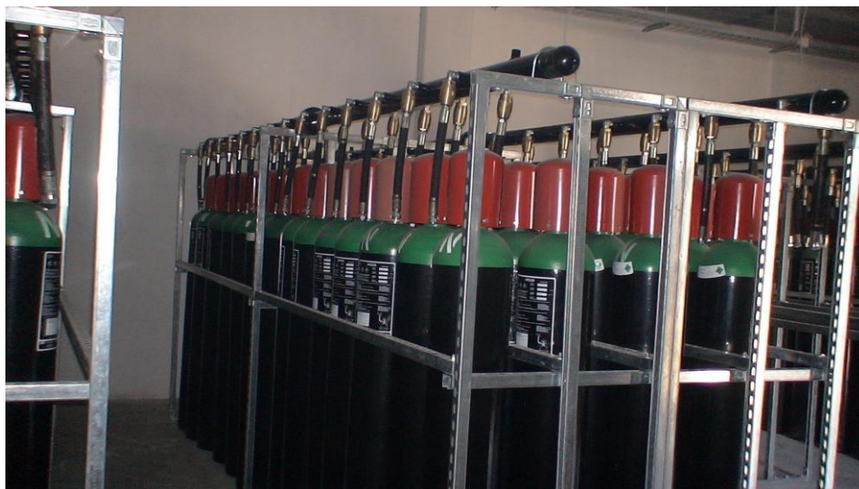
5. sz. kép: Argon gázos oltórendszer 16
